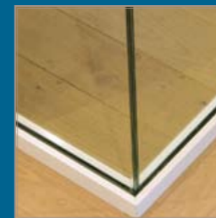
Angles à 90° entièrement collés
